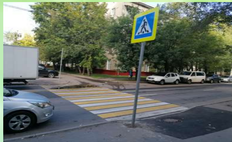
ул. Штурвальная, д. 6 Организация нерегулируемого переходного перехода
