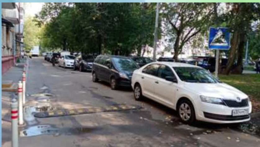
ул. Нелидовская д. 21 Установка искусственных дорожных неровностей
