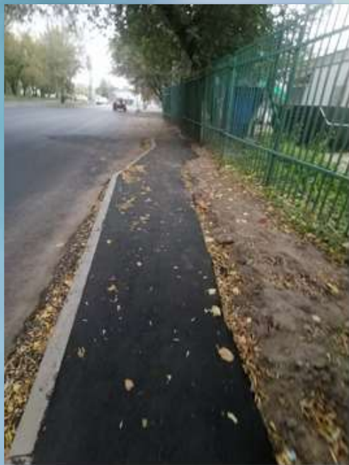
Обустройство тротуара вблизи ООТ «Пр. Донелайтиса, 12»
