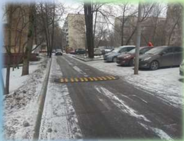
ул. Фабрициуса, д. 10
