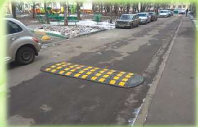
Установка ИДН на дворовой территории ул. Штурвальная
