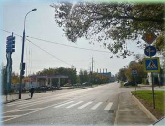
Организация пешеходного перехода на Походном пр-де, д. 9, корп. 1
